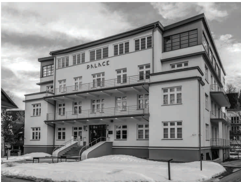
47. Muzeum Palace po remoncie konserwatorskim (2022–2023). Fot. Z. Moździerz, 2025 47. Palace Museum after conservation renovation (2022–2023). Photo: Z. Moździerz, 2025
