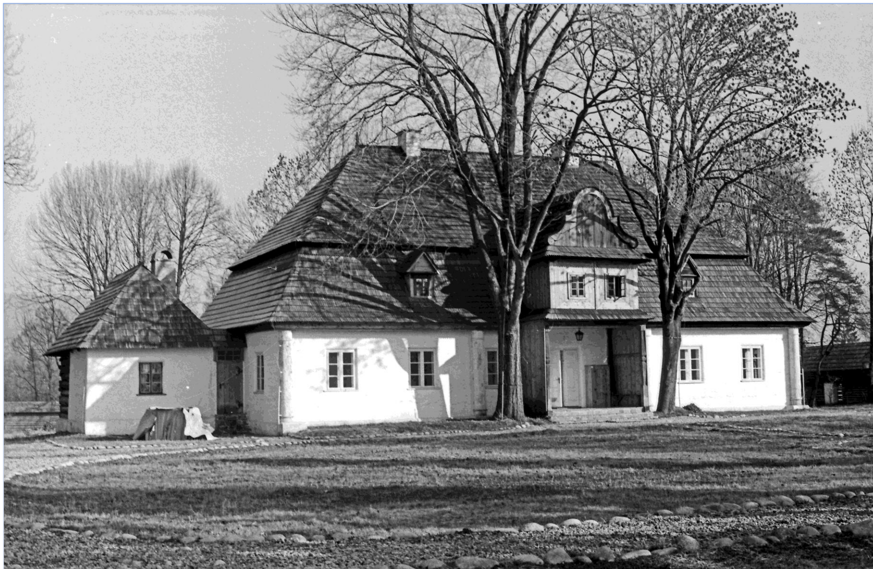
13. Dwór i kuchnia - widok od strony południowo-zachodniej (fot. Zbigniew Moździerz, 1986)
