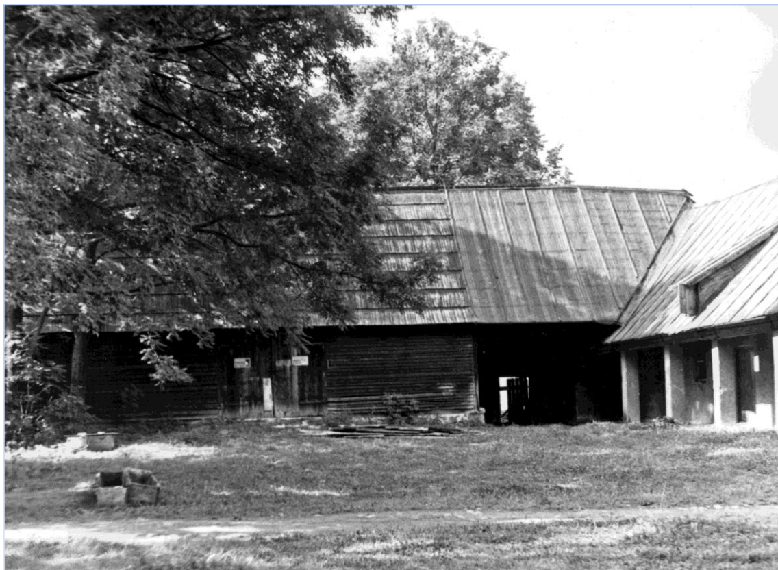
25. Wozownia – widok od północy (fot. Zbigniew Moździerz, 1982)
