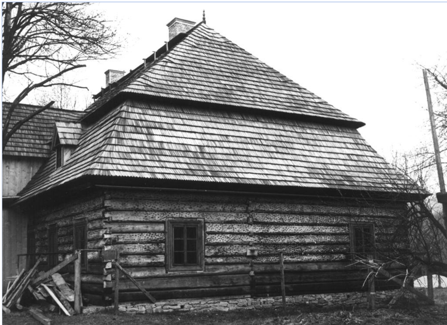
10. Dwór – widok od strony południowo-wschodniej (fot. Ryszard Bukowski, 1982)
