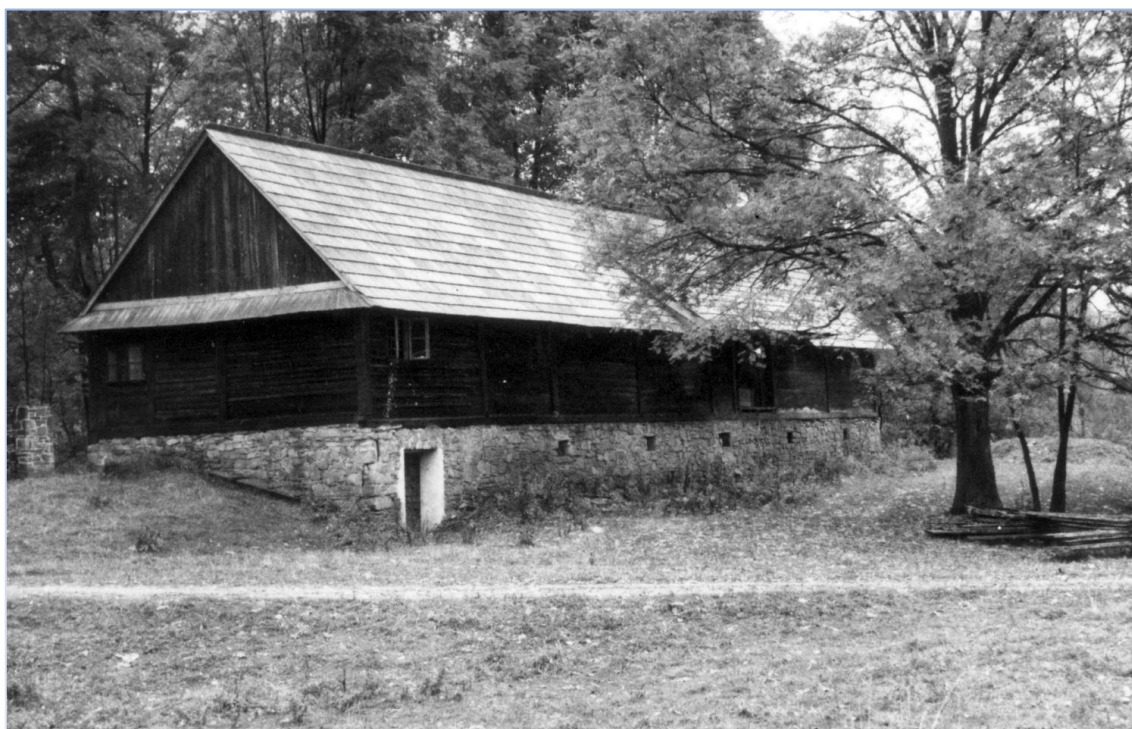
35. Piwnica dworska – widok od strony południowo-wschodniej (fot. J. Krzyszkowski, 1979)
