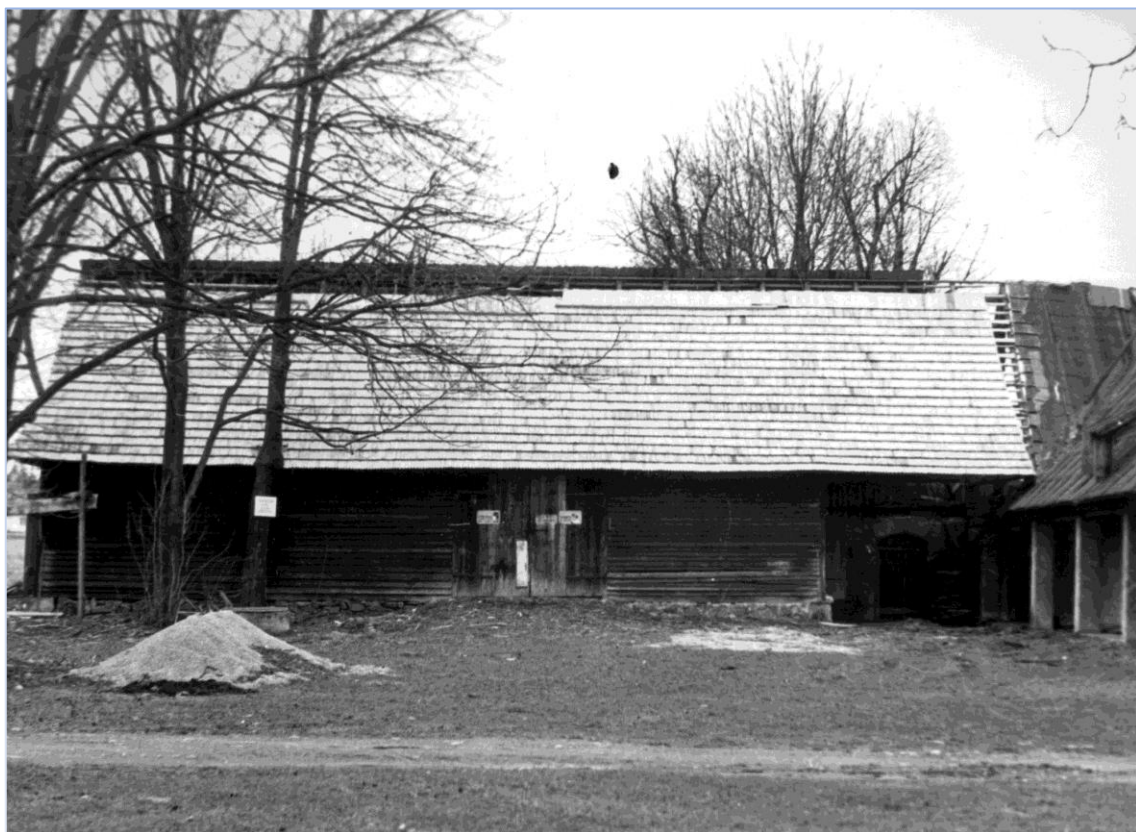
27. Wozownia – widok od północy (fot. Zbigniew Moździerz, 1983)
